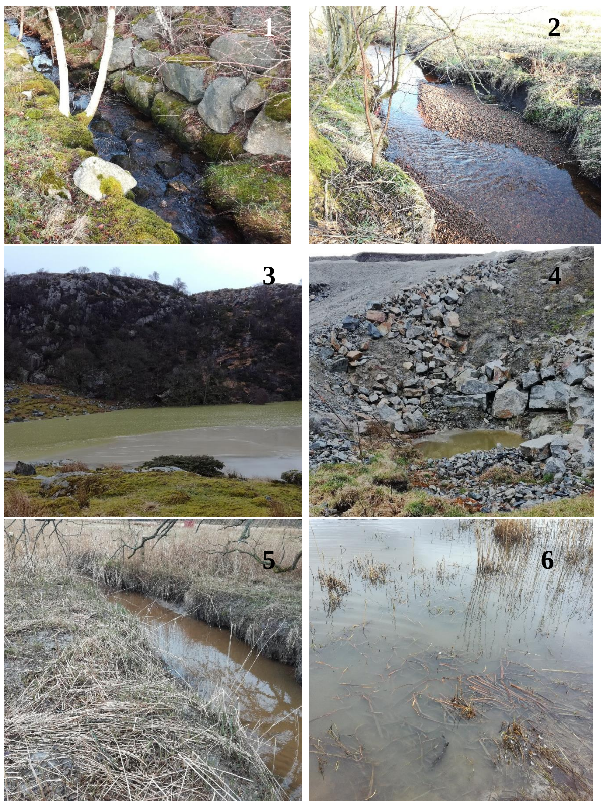
Figur 5. (1) Mosegrodd stein der Skjørestadbekken renner langs Fv.516. (2) Gytegrus i nedre halvdel av Skjørestadbekken. (3) Finstoff fra Veldes vaskeanlegg pumpes til et basseng øst for Ranglefjellet (slamlagune). (4) Fra fyllingen går vannet i rør til sedimentasjonsdammer etablert på Skjørestad. (5 og 6) Videre ned bekkeløpet avsettes finstoff ra slamlagune og massedeponiene langs bekkeløp og i bekkeløp og i utløpssonen, og noe spres ytterligere ut i Grunningen og utløpskanalen.
