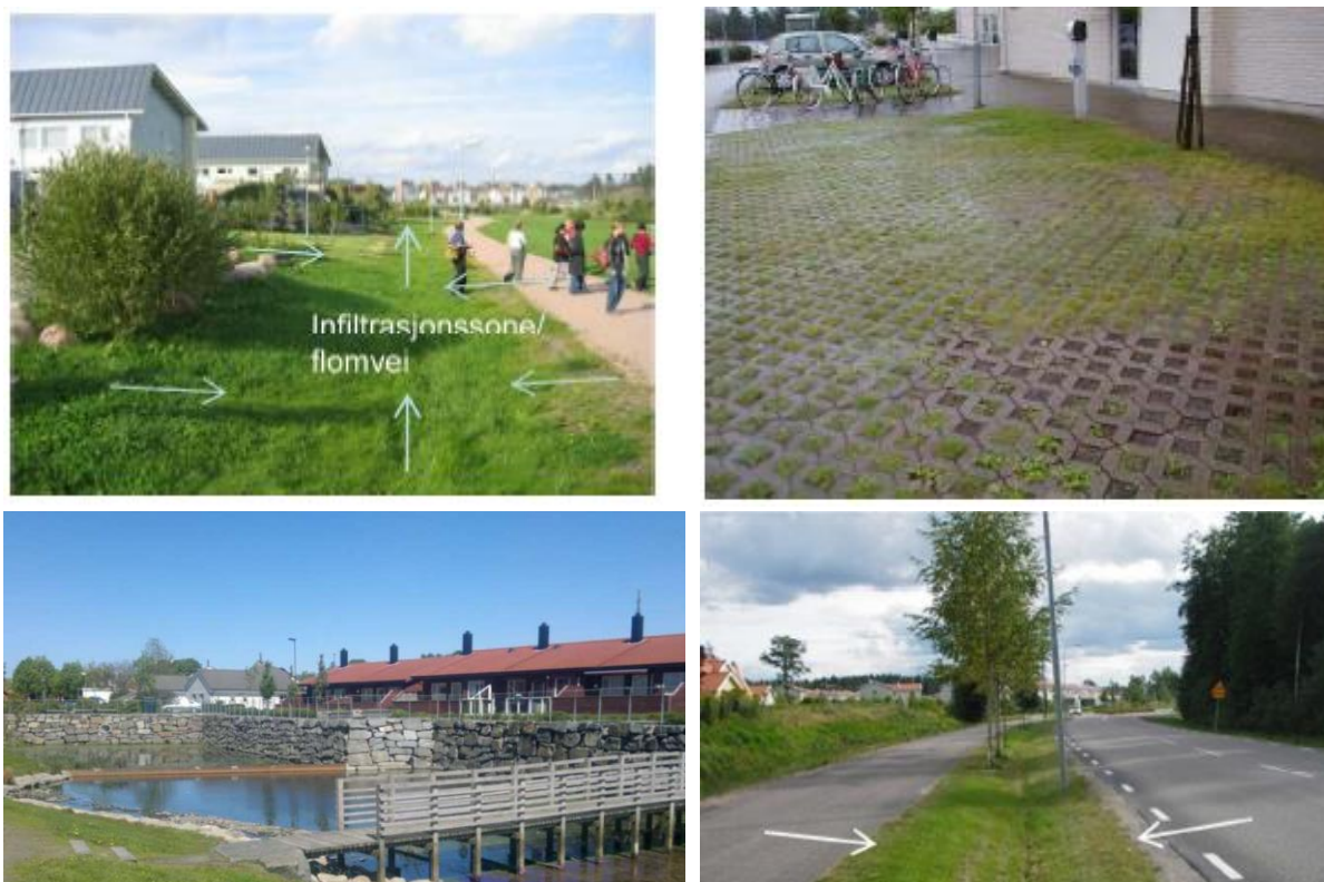
Figur 11.5. Eksempler på åpen overvannshåndtering (Åstebøl m. fl. 2013): Ø.t.v: Eksempel på blågrønn korridor (Infiltrasjonssone/flomvei) i boligområde. Ø.t.h: Eksempel på permeabelt, armert grasdekke. N.t.v: lokal fordrøyningsdam i bebyggelse. N.t.h...: Infiltrasjonssone mellom hovedvei og gang-/sykkelvei.
