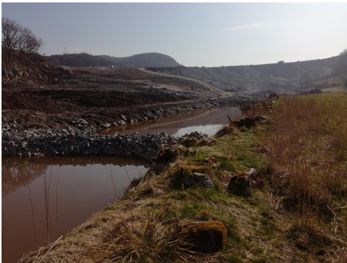
Figur 8.3. Sedimentasjonsbasseng 2 i forgrunnen og massedeponiet i bakgrunnen
