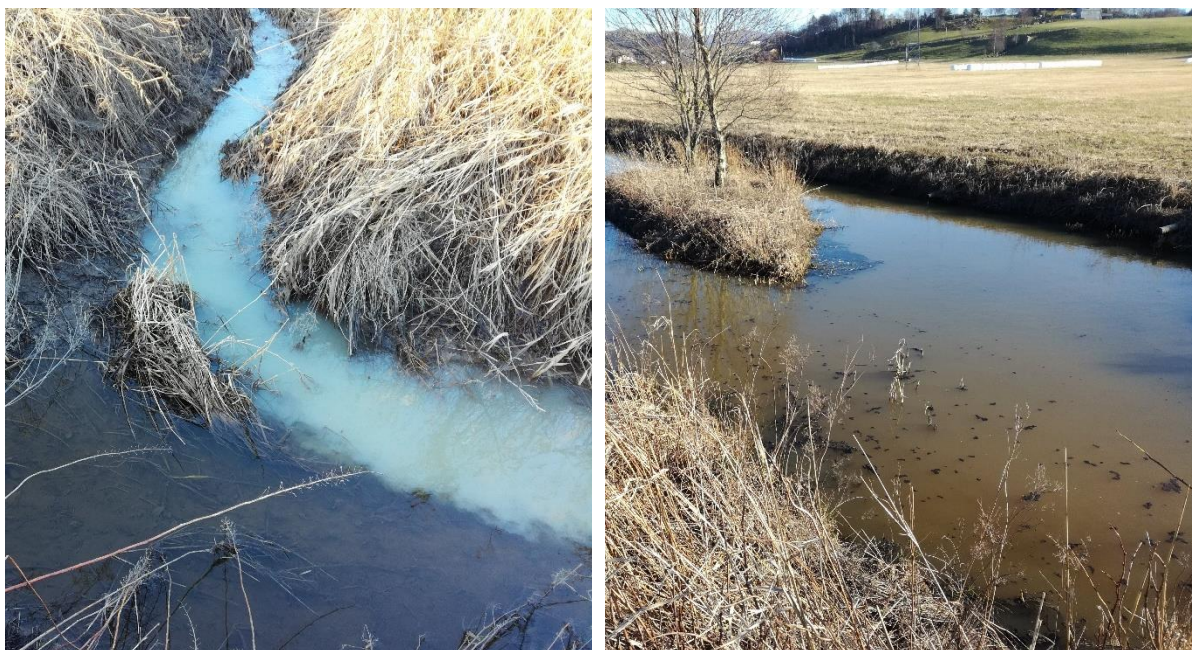
Figur 3. Pågående utslipp fra anleggsområder som dette på Hana gir stor tilslamming av vannforekomsten (her rensedammen i Auestadkanalen), og reduserer effekten av rensetiltakene som er tiltenkt landbruksavrenning.
