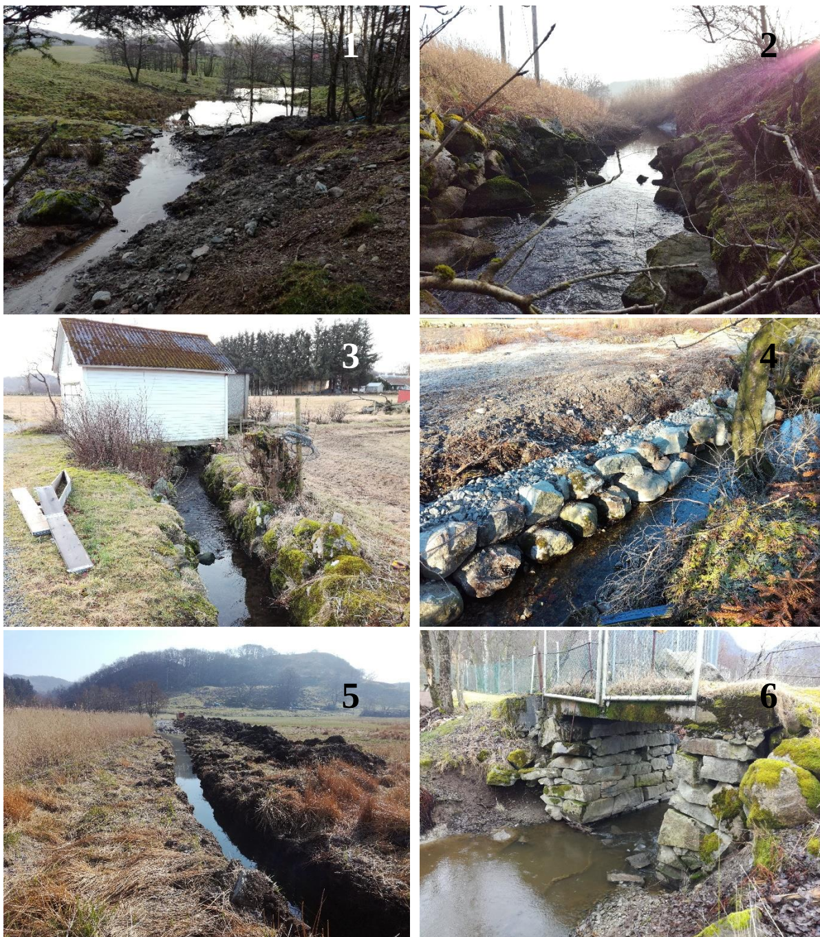
Figur 6. (1) Vedlikehold av vannveier ved innløp til rensedammen som mottar vann fra (bekk fra Hana). (2) Auestadkanalens utløpssone til Grunningen ligger dypt. (3) Vatnebekkens smaleste løp har steinsatte sider, bråe svinger og flere strukturer langs elvebanken. (4) Nyetablert steinsetting langs bekkeløpet nedstrøms Skjørestadbekkens veikrysning (fv.516). (5) Opprensning av kanalløpet i bekken fra Breidmyra. (6) Bro over utløpskanalen
